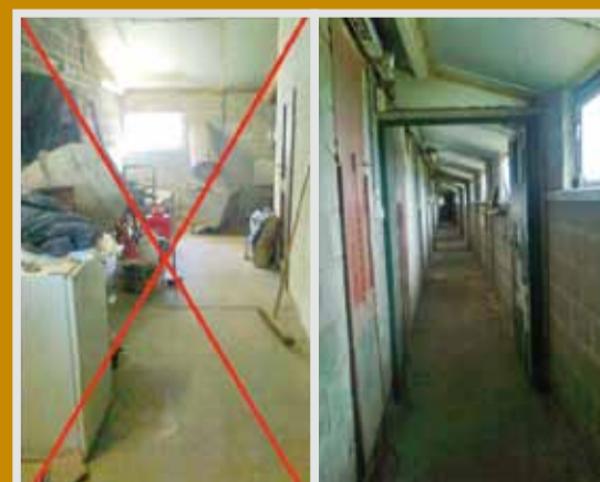
Les couloirs bien dégagés sont très faciles à nettoyer et à désinfecter après le passage des animaux ou du personnel
